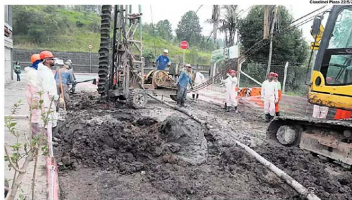
SANTO ANDRÉ. Equipes atuam na construção de microrreservatórios previstos no Plano de Drenagem
