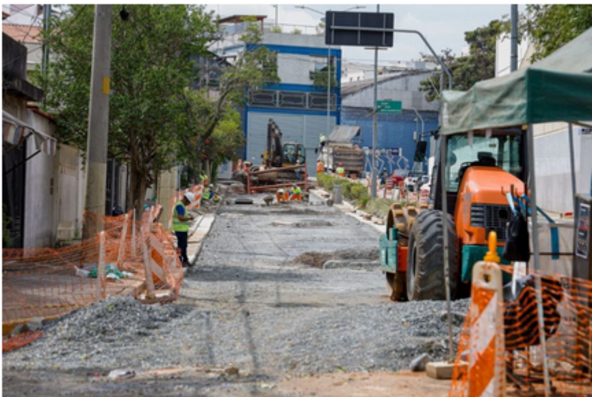
Obras do Drenar São Caetano nas avenidas Fernando Simonsen e Nelson Braido entram na fase final. Foto: Divulgação
