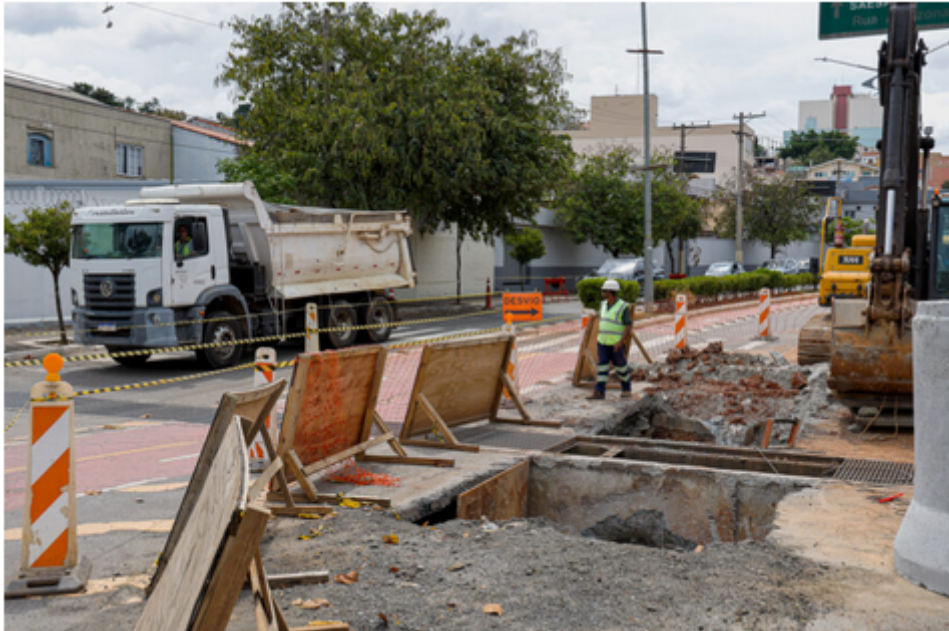
Obras Drenar São Caetano – Avenidas Fernando Simonsen e Nelson Braido – Eric Romero / PMSCS
