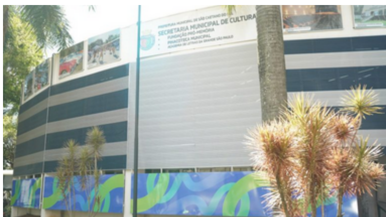
Fachada da Fundação Pró-Memória de São Caetano do Sul e Pinacoteca Municipal. Foto Samue
