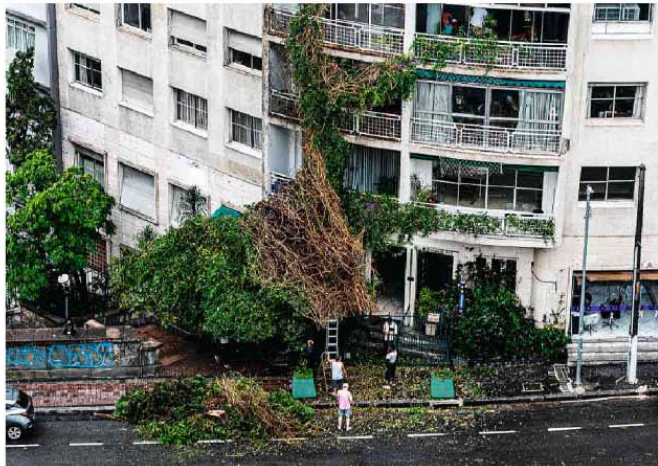
Vento e chuva fortes derrubam trepadeira do edifício Major Quedinho, na região central de São Paulo, onde foram filmadas cenas do filme 'Ainda Estou Aqui' Fotos Rafaela Araújo/Folhapress
