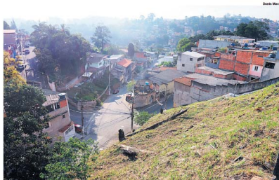
INTERVENÇÃO. No bairro Eldorado, em Diadema, serão realizadas obras para contenção de encosta
