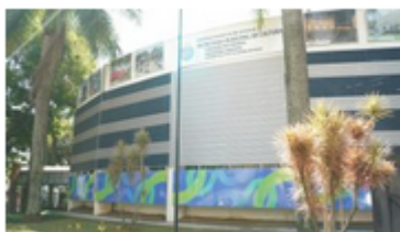
Fachada da Fundação Pró-Memória de São Caetano do Sul e Pinacoteca Municipal. Foto Samuel Tchalla Secult PMSCS_3
