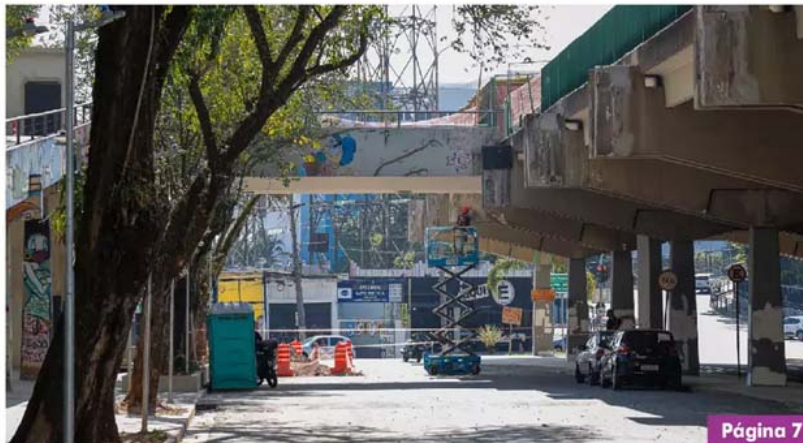
Demolição de estruturas antigas, reparos em pilares e rampas acessíveis garantem progresso visível e evitam transtornos aos usuários
