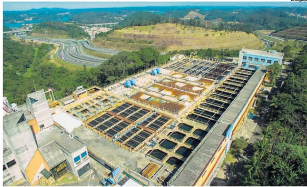
SISTEMA. A Estação de Tratamento de Água Rio Grande, em S.Bernardo, integra o abastecimento na região
