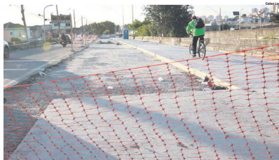
CANTEIRO DE OBRAS. No lugar de pessoas trabalhando, o vazio vira símbolo do BRT-ABC
