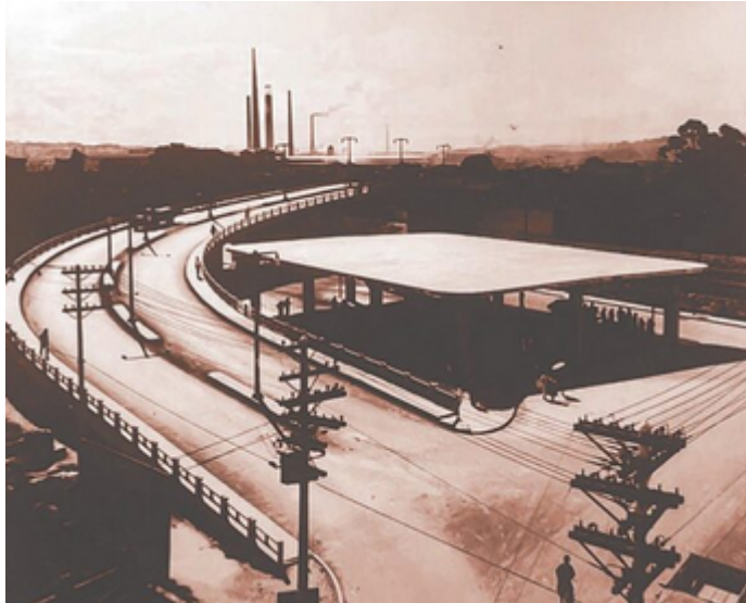
Viaduto dos Autonomistas construído durante a administração do prefeito Anacleto Campanella em seu primeiro mandato em 1954
