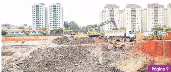
Trabalhadores e máquinas atuam na instalação das últimas vigas de coroamento, etapa fundamental para a continuidade da construção do reservatório
