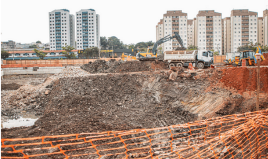
Instalação de tirantes de estabilidade marca nova fase do Piscinão do Fundação em São Caetano - Foto: Gabriela Gonçalves/PMSCS
