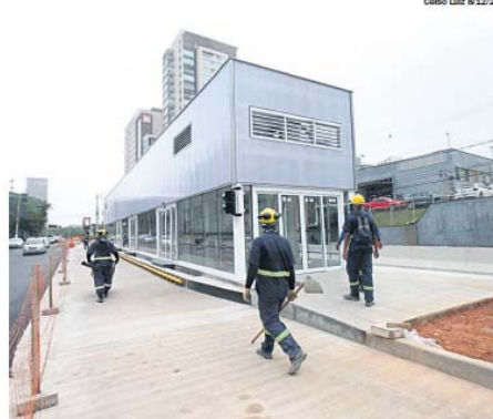
BRT. Projeto prevê corredor exclusivo de 17,3 km com 92 ônibus
