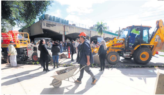
MÃOS À OBRA. Funcionários deram início ontem ao projeto de revitalização do módulo 2 do Terminal Rodoviário Nicolau Delic, localizado no Centro de São Caetano
