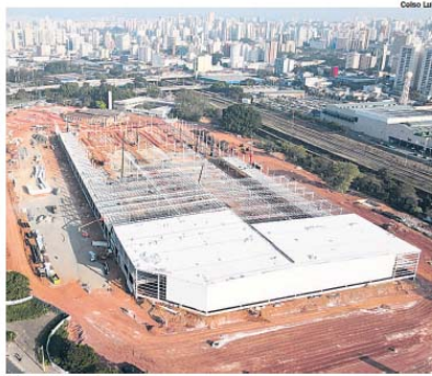
OBRAS. Galpões começam a tomar conta do terreno da antiga Rhodia
