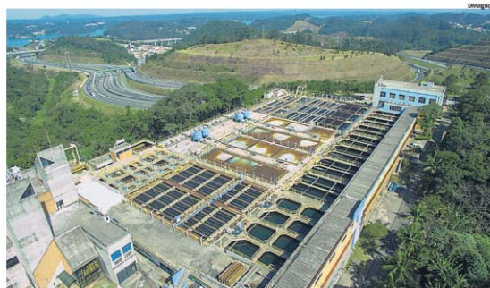
BEM-ESTAR. Obras, como essa estação de tratamento de água em S.Bernardo, impactam na saúde pública
