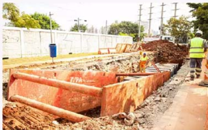
Diante da grandiosidade das obras, a Prefeitura estruturou uma equipe de comunicação exclusiva para atender a população
