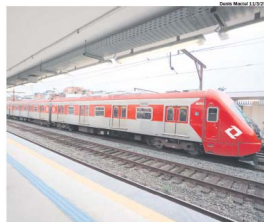
ALÇAMENTO. Obras podem dar fim aos alargamentos de vias
