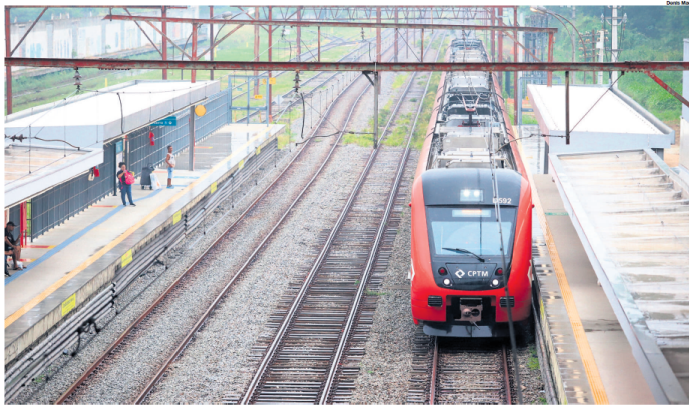
RENOVAÇÃO. Estação Uttinga, a exemplo da Prefeito Saladino, será reconstruída após a privatização, inclusive com projeto de alçamento da linha férrea
