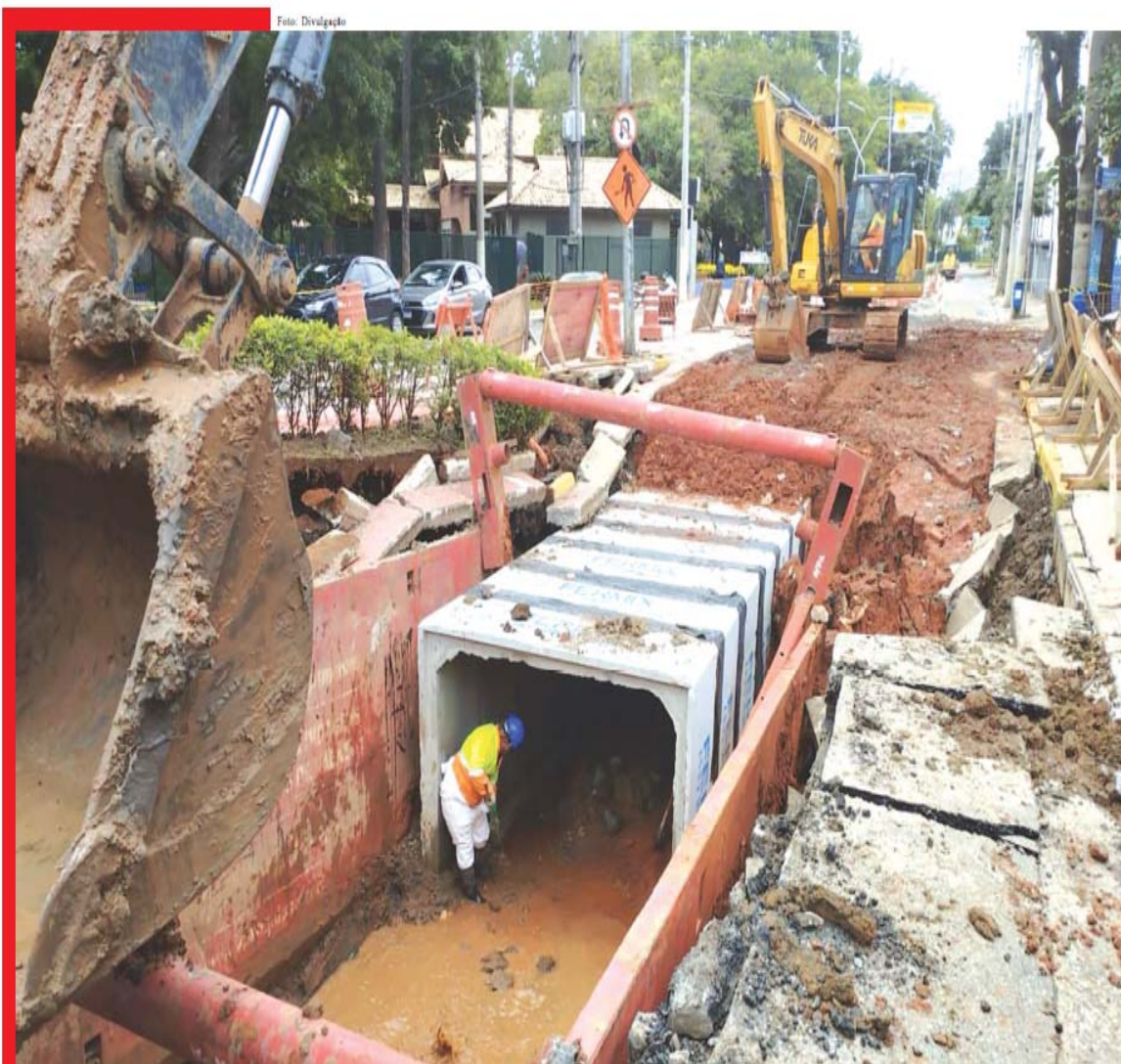
AVENIDA Fernando Simonsen está recebendo novas tubulações em toda a sua extensão
