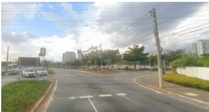
Obras na Av. Nelson Braido com Av. Guido Aliberti - Foto: Divulgação/PMSCS
