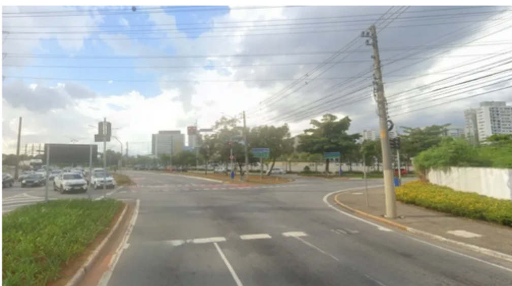
Obras na Av. Nelson Braido com Av. Guido Aliberti alteram fluxo viário em São Caetano. Foto: Divulgação
