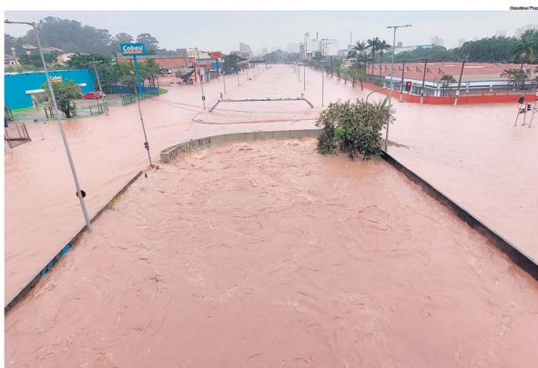
CADÊ O ASFALTO? Rio Tamanduaí transbordou e alagou a Avenida dos Estados em Santo André, impedindo o trânsito em ambos os sentidos
