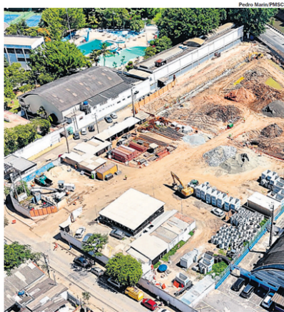
PROJETO. Piscinão funcionará como uma estação elevatória
