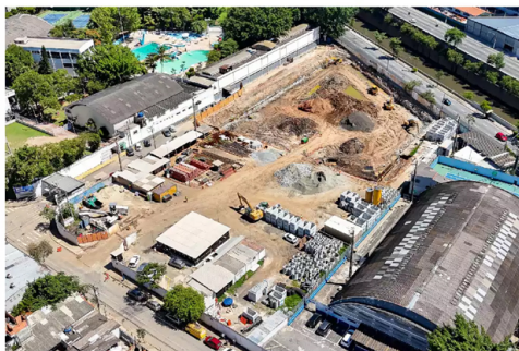
O reservatório faz parte do Refundação, que é o maior pacote de obras contra enchentes do histórico de São Caetano, com R$ 173,4 milhões investidos
