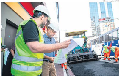
PRESENÇA. Tite Campanella acompanhou as obras de remoção da ciclovia e demarcação de vagas
