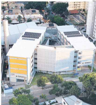
INACABADAS. Escolas municipais que foram entregues por Auricchio fazem parte de complexo que ainda está em obras
