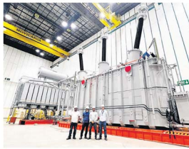
GIGANTE. Transformador está sendo instalado em São Caetano
