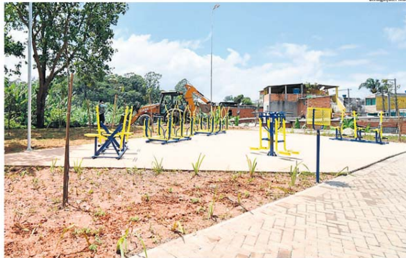
URBANIZAÇÃO. As obras no Jardim Serro Azul, em São Bernardo, beneficiaram 492 famílias
