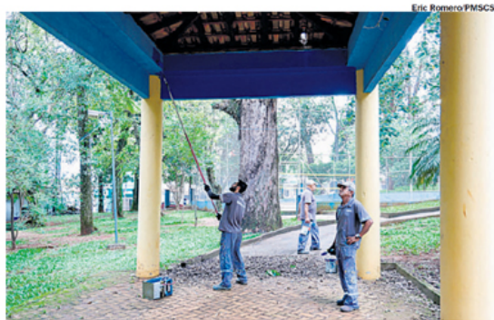
REFORMA. Funcionários da Prefeitura trabalham na pintura do parque
