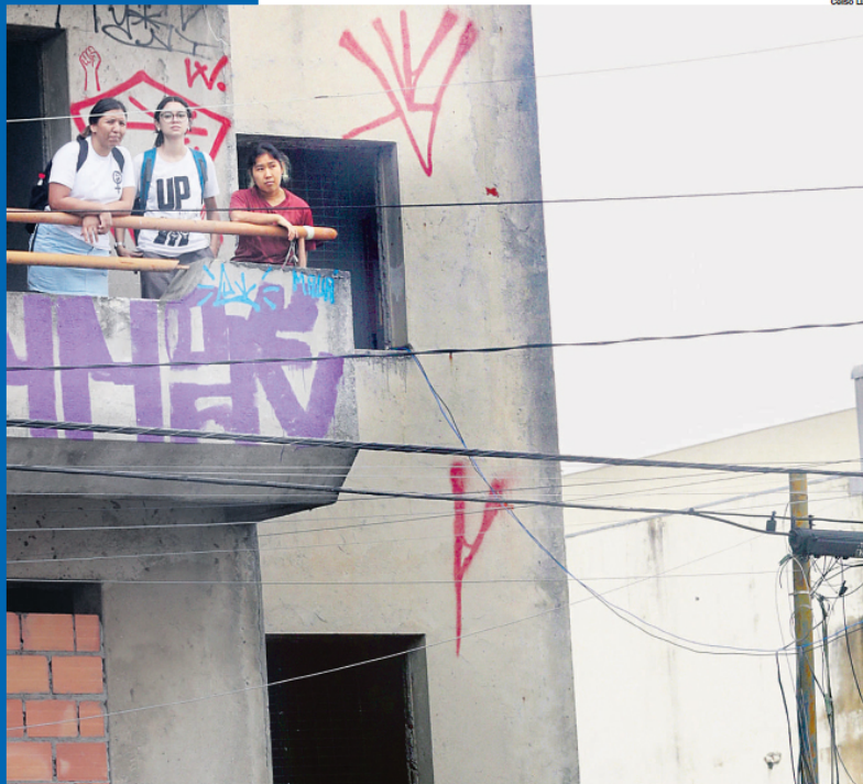
'GATO'. Ligação clandestina feita em poste serve para abastecer prédio invadido
