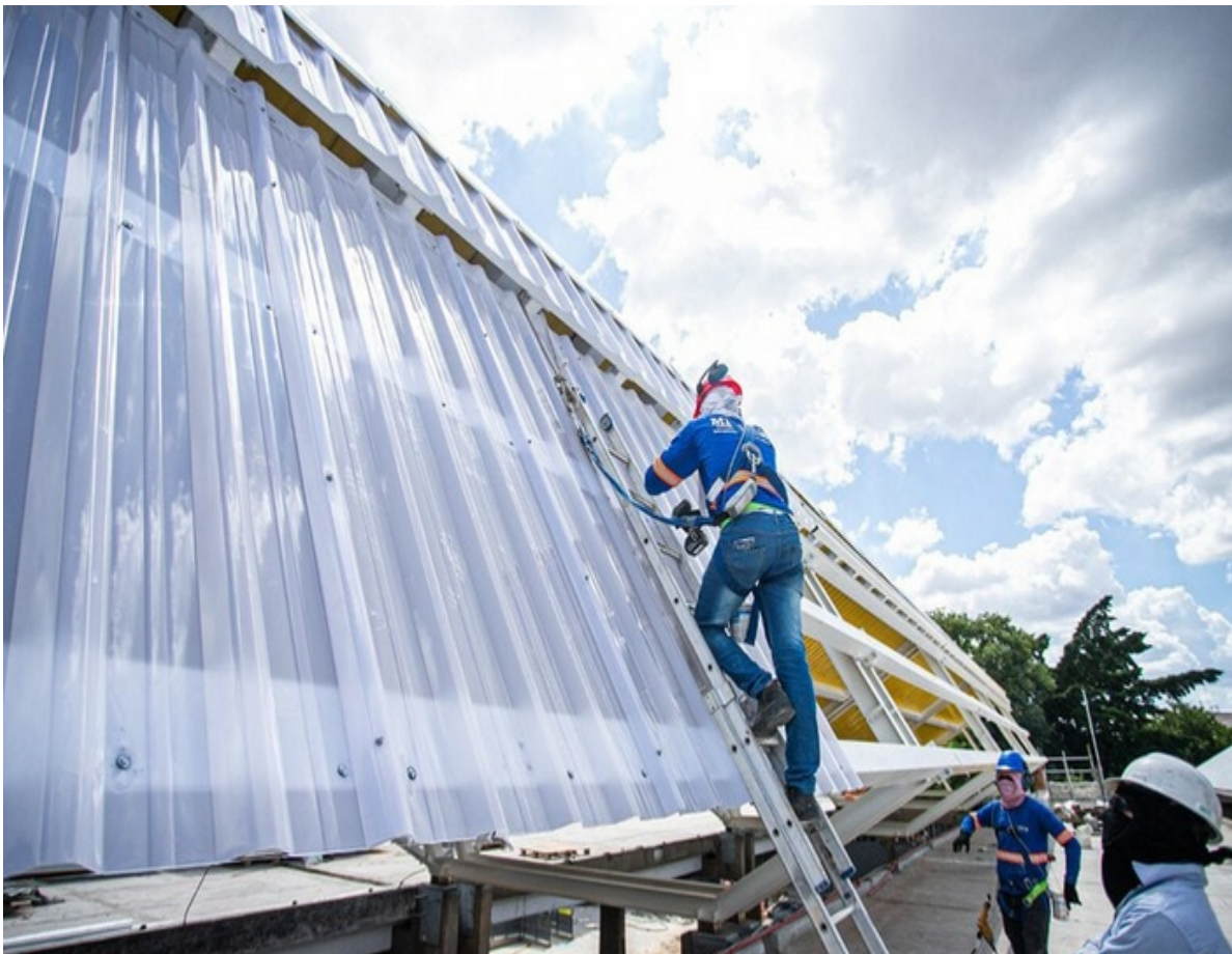
Instalação de nova cobertura no Terminal Nicolau Delic, em São Caetano, entra na reta final. Foto: Divulgação
