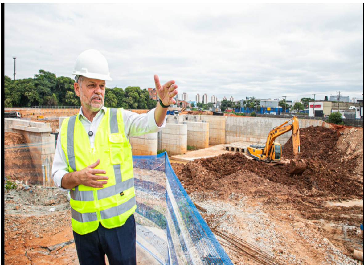
Prefeito de São Caetano do Sul, Tite Campanella, vistoria obras do piscinão: cerca de um milhão e meio de pessoas serão beneficiadas (Gabriela Gonçalves/Divulgação/PMSCS)
