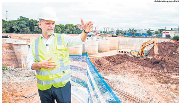
VISTORIA. Tite foi ao canteiro de obras para acompanhar andamento da construção do reservatório
