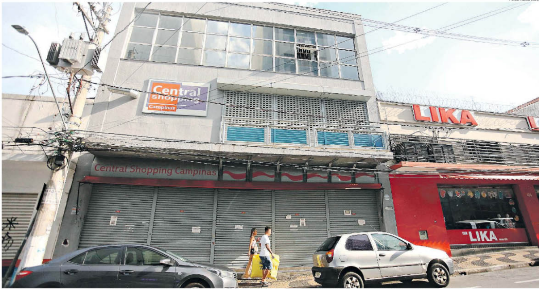
Imóvel localizado na Rua Costa Aguiar é um dos que estão com processo para aplicação da Lei do Retrofit sob análise da Prefeitura
