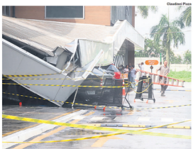
MERCADO. Marquise de unidade do Sonda caiu sobre carros estacionados
