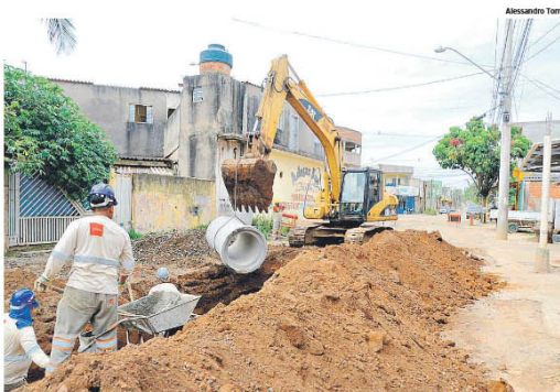
Outra obra já iniciada e em fase de conclusão é a pavimentação dos bairros Campo Belo I, II e III; outros bairros e vias importantes da cidade devem receber melhorias neste início de ano, de acordo com o plano
