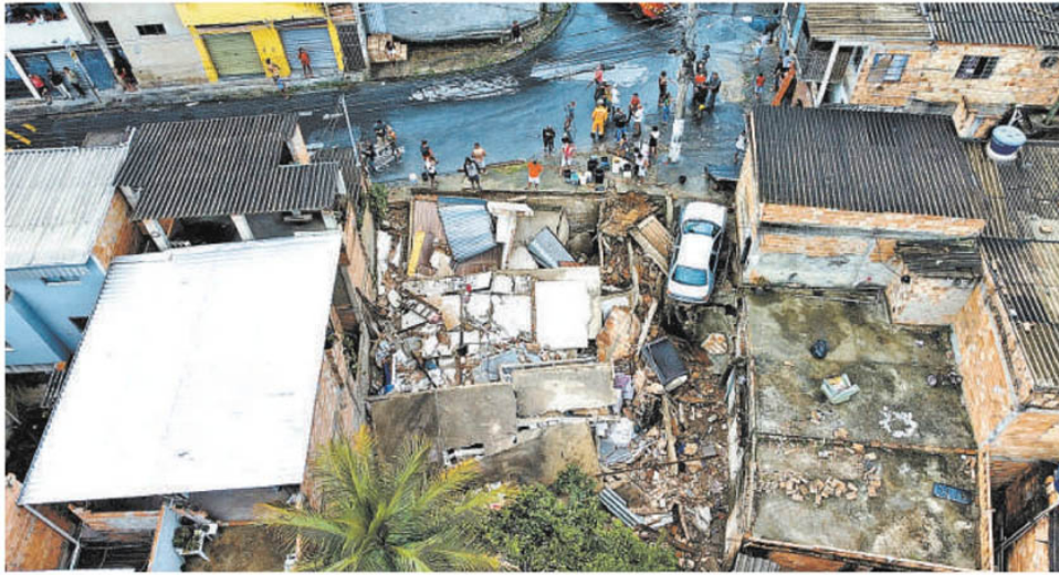
CHUVA PROVOCOU QUEDA DE UMA CASA DE DOIS ANDARES NO BAIRRO CONJUNTO PAULO VI, REGIÃO NORDESTE DE BELO HORIZONTE, QUE DESABOU SOTERRANDO QUATRO PESSOAS
