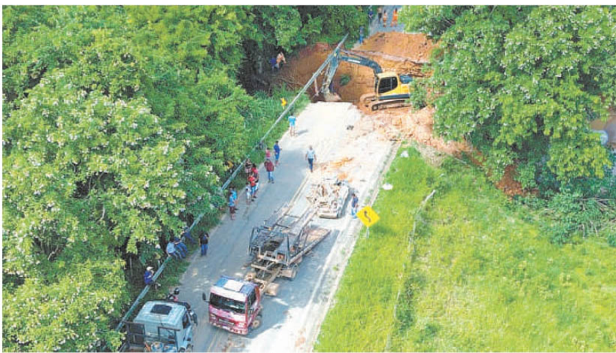
OS TRABALHOS DAS EQUIPES DE RESGATE, QUE INCLUÍRAM ESCAVAÇÕES E DESENCARCERAMENTO DAS VÍTIMAS, SE ESTENDERAM PELA MADRUGADA. A ESTRADA ESTÁ INTERDITADA
