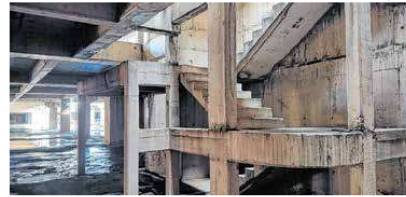
Escadaria do estacionamento
