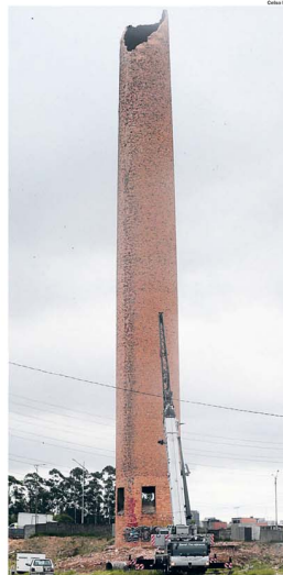
PARALISAÇÃO. Demolição da chaminé já havia sido iniciada
