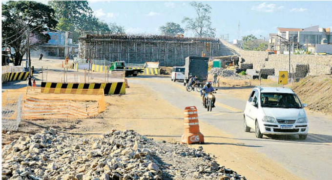
Departamento de Estradas de Rodagem informou que 72,3% das obras de duplicação e modernização da SP-324 já foram concluídas; viaduto sobre a Estrada Velha de Indaiatuba está finalizado, assim como uma das quatro passagens inferiores que interligam os bairros
