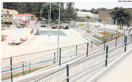
SO CIMENTO. Não há grandes árvores que façam sombra no local, apenas mudas que foram plantadas
