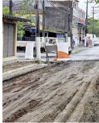
Obras de acesso ao aeroporto, na Avenida Gonzales de Conde
