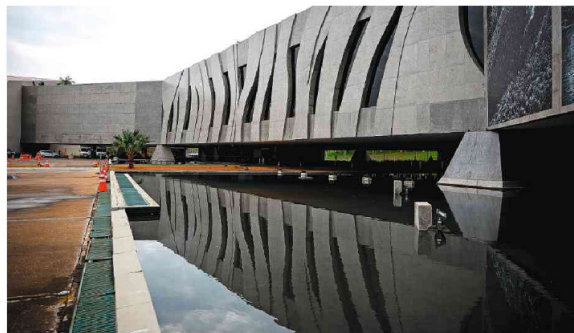
Fachada da sede do STJ (Superior Tribunal de Justiça), em Brasília. Pedro Ladeira - 28 ago.23/Folhapress
