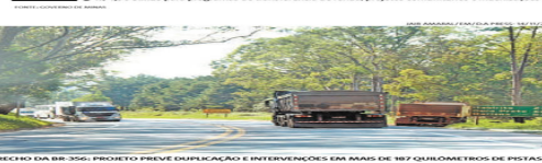
TRECHO DA BR-356. PROJETO PREVÊ DUPLICAÇÃO E INTERVENÇÕES EM MAIS DE 187 QUILOMETROS DE PISTAS
