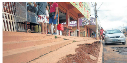
Força da correnteza danificou até calçadas construídas acima do nível do chão
