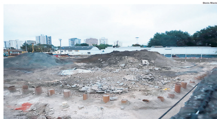
PISCINÃO. Reservatório terá capacidade para armazenar 18.500 m³ de água em pleno funcionamento
