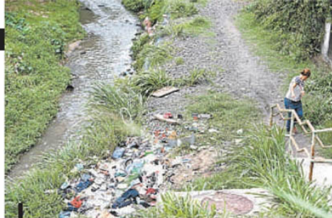
DRENAGEM ESTREITA DO CÓRREGO ISIDORO, EM VENDA NOVA, É CERCADA POR DESCARTES IRREGULARES DE LIXO, AUMENTANDO AINDA MAIS O RISCO DE ALAGAMENTOS
