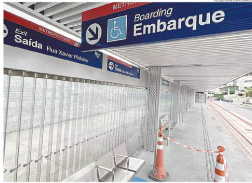
Estações de embarque e desembarque já fazem parte da paisagem nos trechos em que foram instaladas
